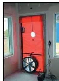
Blower Door Test
